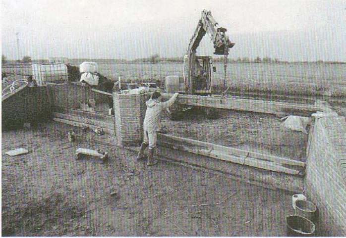
De schotbalkensluis na restauratie (foto: Jacques van der Neut)
