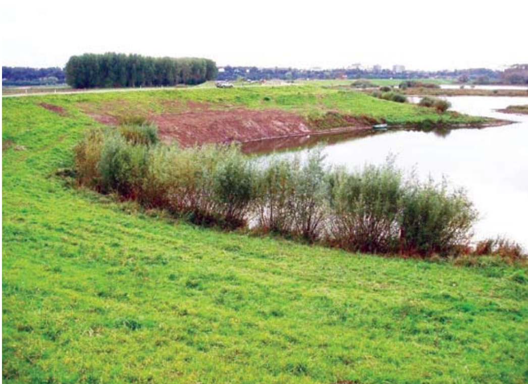
Hersteld dijktafud na graverij door bevers. Ooijse Bandijk 2004.
