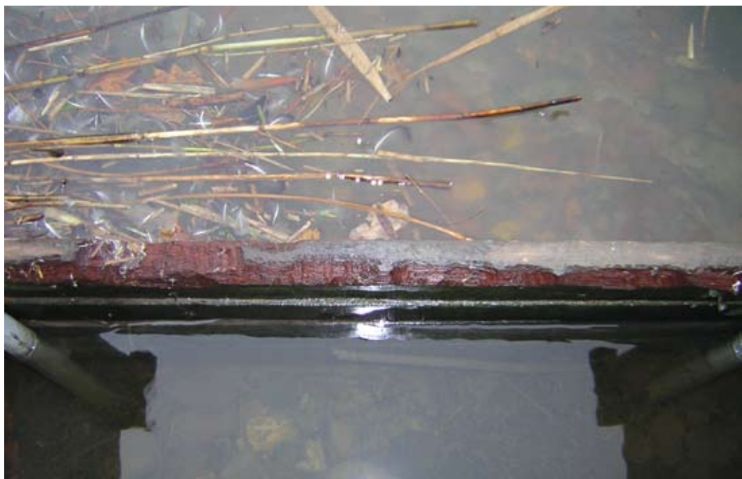
Vraat aan houten stuwte langs de Kroonbeek in Noord-Limburg (26-11-2004) (foto Waterschap Peel en Maasvallei).
